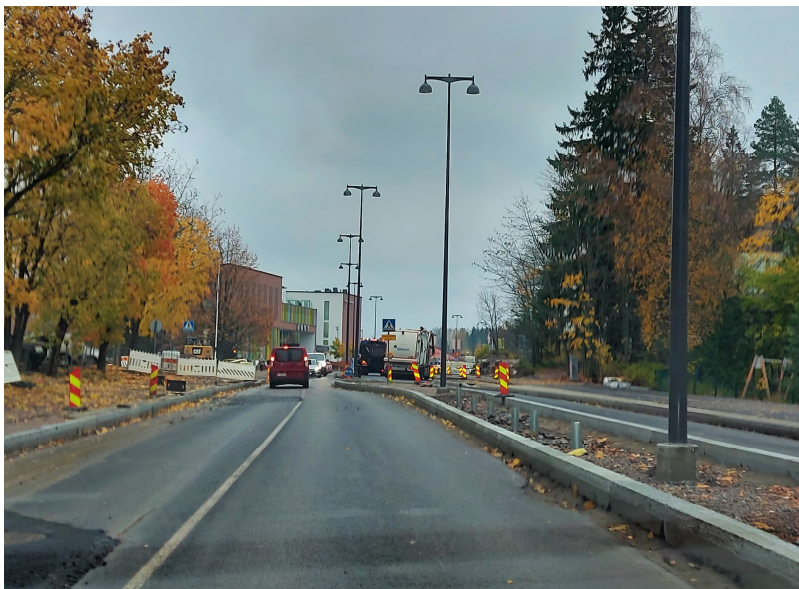
Katuvalaisimia uusitaan sekä erikseen, että peruskorjausten yhteydessä. Kuva Helsingintien peruskorjauksesta vuodelta 2020.
